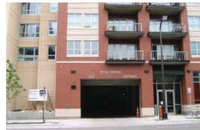
Garage door placement
